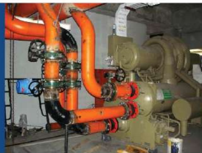
ระบบเครื่องทำความเย็น ซิลเลอร์-คูลลิ่งทาวเวอร์ Chiller-Cooling Tower System
